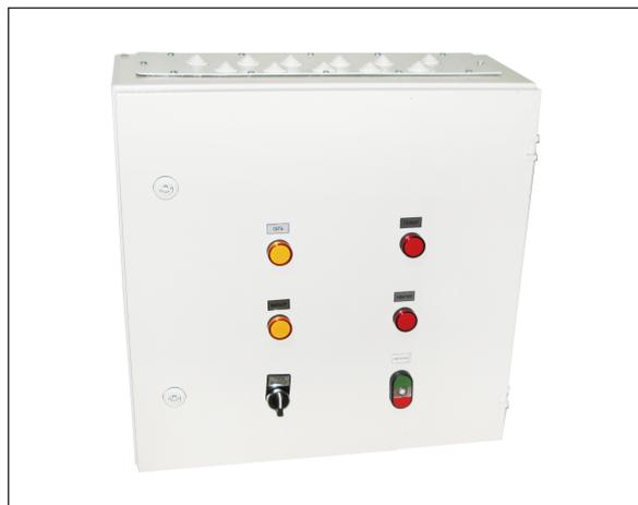
Шкаф АСВ - типового решения №1, модификации №4 для управления приточной установкой КЦКП в составе: вентилятор мощностью 0,75 кВт (управление с помощью частотного преобразователя), наружный клапан с приводом LF230-S, фильтр, нагреватель водяной (с трехфазным насосом мощностью 0,45 кВт).
